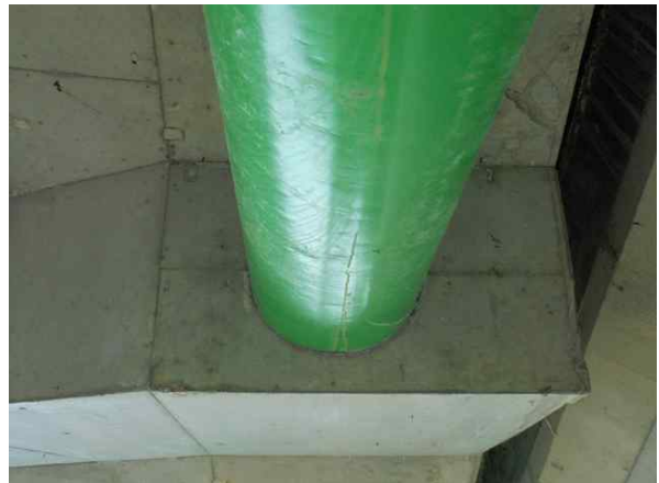
가로보 스트럿 상태양호
