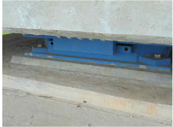
P2-Sh3 받침물탈균열 보수
