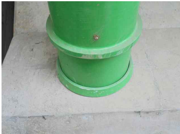
가로보 스트럿 상태양호
